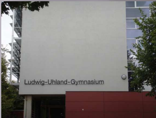
Ludwig-Uhland-Gymnasium Kirchheim-Teck Ausführung: Ing.-Büro Nägele, Stuttgart Klassenräume, Lehrerzimmer, Flure
